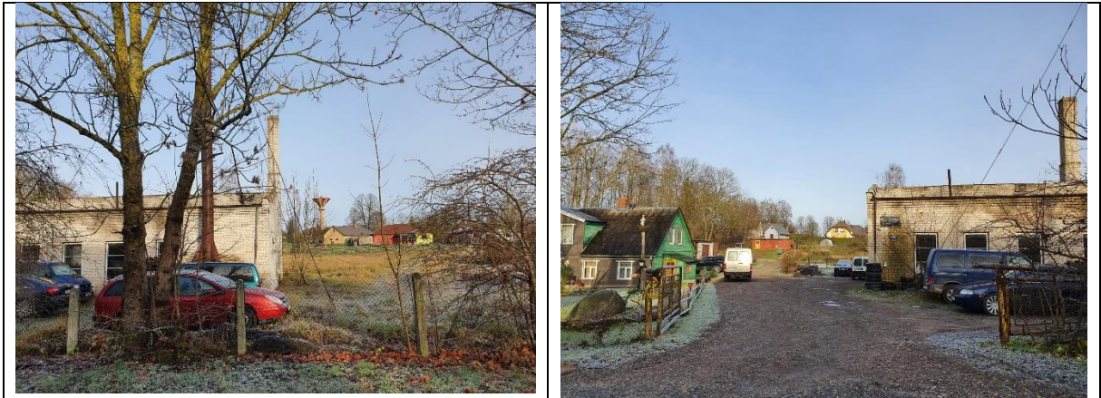
3.-4.att. Bijušās katlumājas ēka
