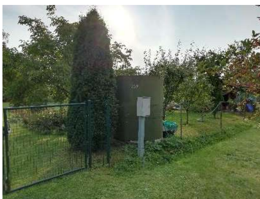
28.-34.attēls. Ūdensapgāde laistīšanai
