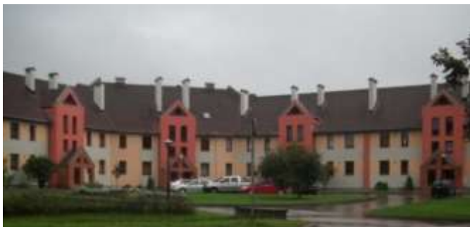
2.27.a att. Renovēta daudzdzīvokļu ēka Saldus pilsētā
