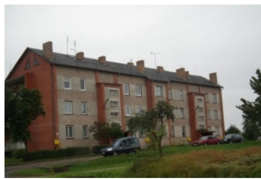
2.28.b.att. Daudzdzīvokļu ēka Ezerē
