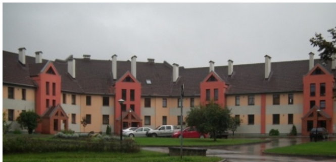
2.26.a.att. Renovēta daudzdzīvokļu ēka Saldus pilsētā
