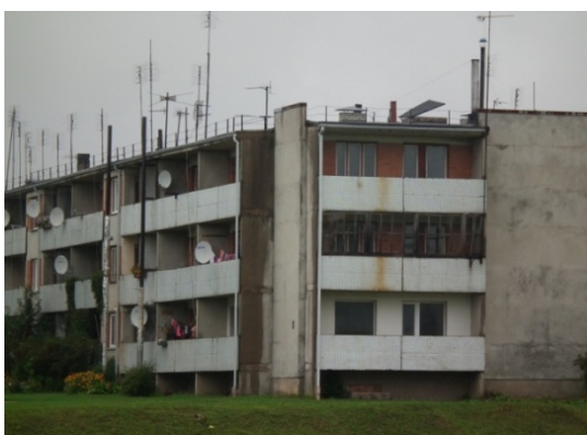
2.17. att. Individuālas apkures sistēmas daudzdzīvokļu ēkā, Kursišu ciemā
