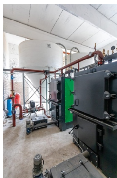
2.12.c. att. Jaunie granulu katli Druvas ciema katlu mājā
